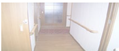
介護保険バリアフリー住宅改修手すり取付工事の一例。
